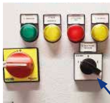
Invertitore di fase solo versione con contatore di partecelle ICM2.0
